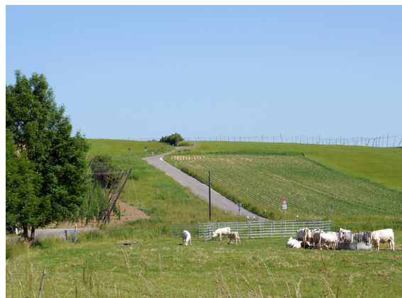
Neue Gemeindeverbindungsstraße nach Seibersdorf
