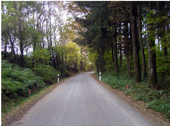
Ausgebaute Gemeindeverbindungsstraße bei Ehrenberg
