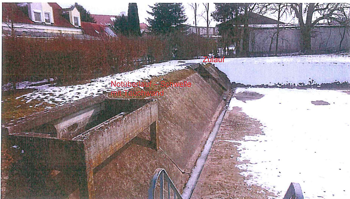
Abbildung 3-2: RRB Geisenfeldwinden mit Zulauf- und Überlaufbauwerk
